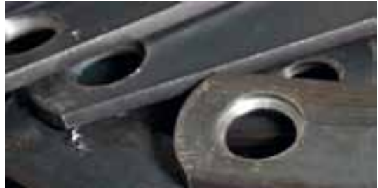
De inre brickorna fasas innan hylsorna svetsas.
